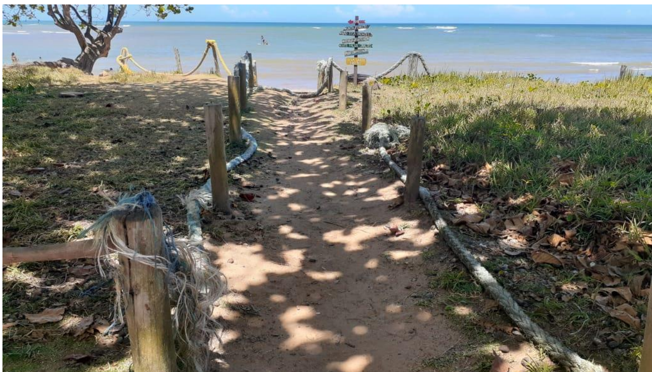
Legenda: Acesso à praia com as benfeitorias deterioradas.
